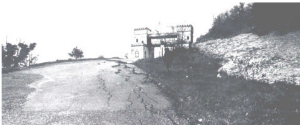
Figura 5 Un'immagine di uno dei tanti eventi franosi dovuto al dissesto idrogeologico causato dai lavori per la costruzione del centro turistico. In questo caso, si tratta delle frane che sconvolsero e distrussero la strada da Olginate a Consonno nel 1980. La costruzione visibile sullo sfondo è l'arco di ingresso al centro di divertimenti e di turismo.
