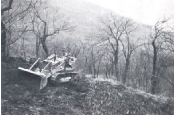
Foto 4 Una delle ruspe impegnate nell'escavazione del tracciato della nuova strada
