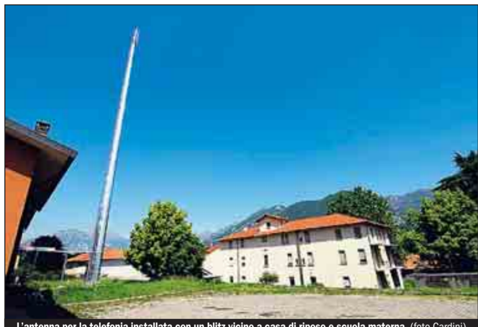
L'antenna per la telefonia installata con un blitz vicino a casa di riposo e scuola materna (foto Cardini)
